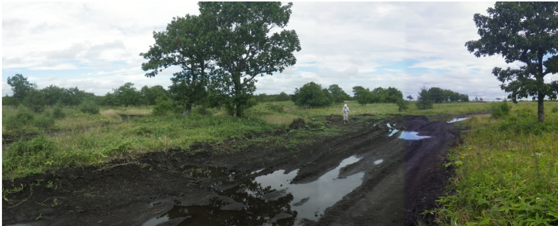
写真② 降雨後の状況
