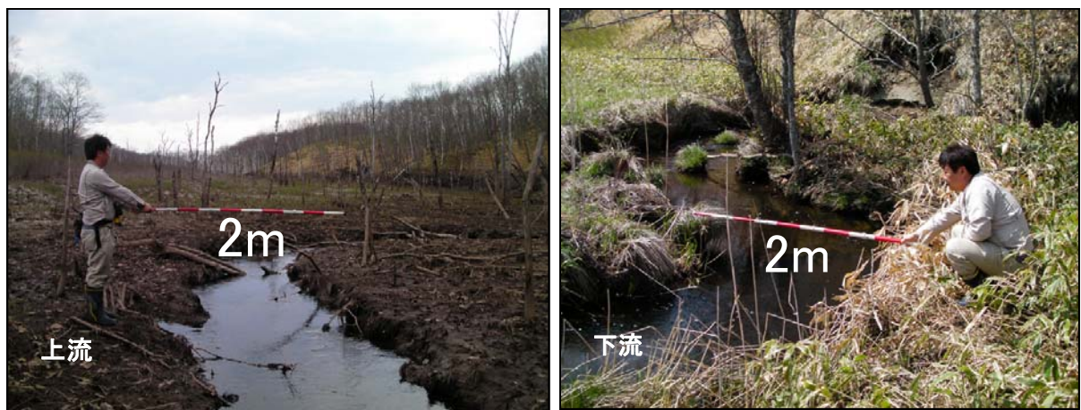
写真 4.2 楓沢第2号砂防ダム上下流の流路(左;上流、右;下流)
