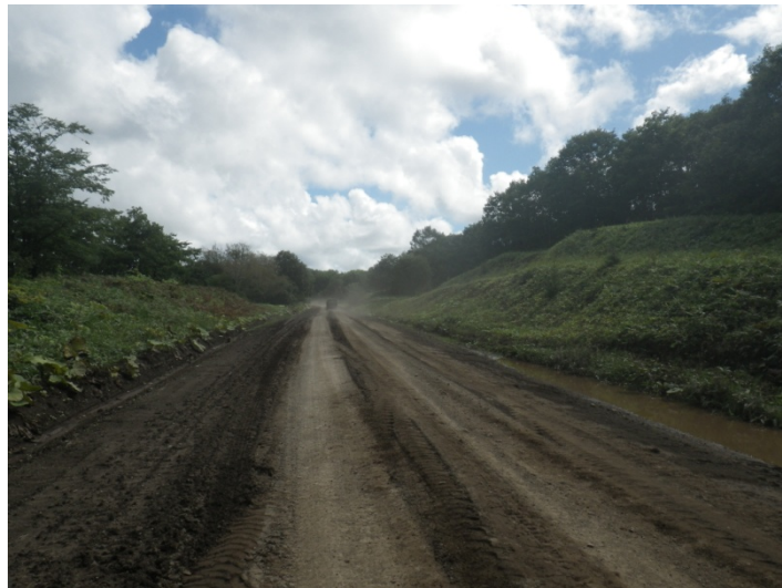
写真③ 降雨後の状況
