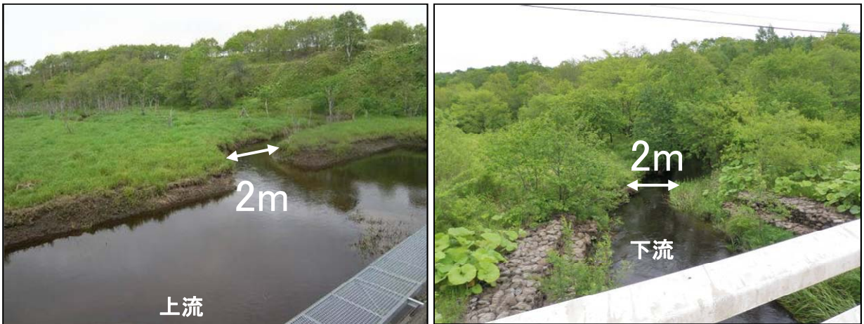
写真 4.1 玉川第1号砂防ダム上下流の流路（左；上流、右；下流）
