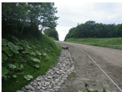
側溝整備（砕石装甲）
