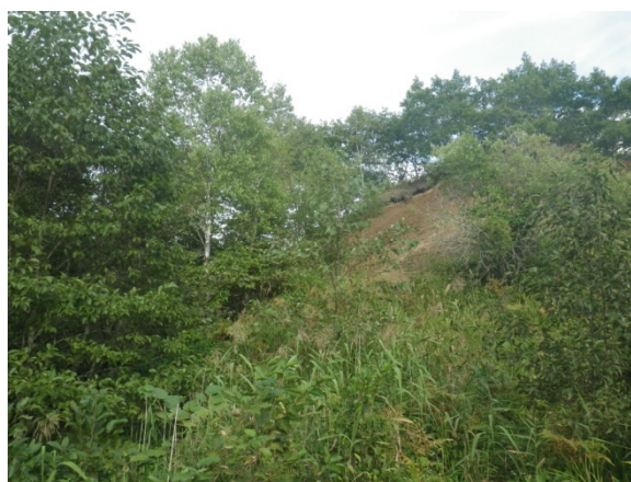
写真① 河道沿いの自然崩壊 玉川本川に面した斜面で自然崩壊が発生している。 崩壊土砂は直接河川に流入している。
