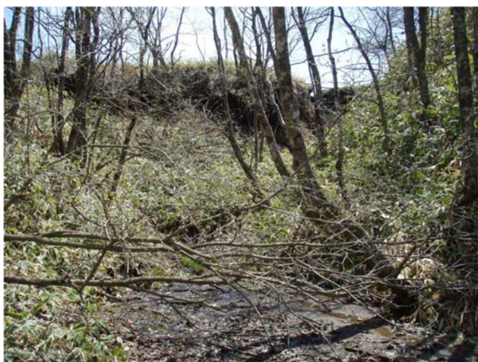
写真③ 谷底部の状況 流入した土砂が谷底に堆積している。
